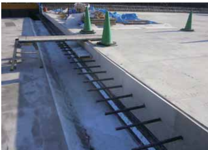
⑦先行型枠脱型完了
