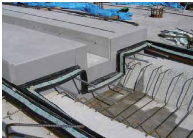
⑧先行型枠脱型完了
