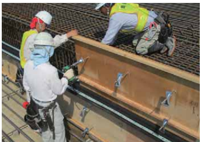
④ 型枠設置状況
