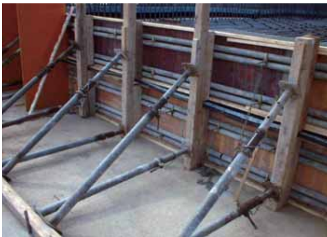
⑤型枠設置完了
