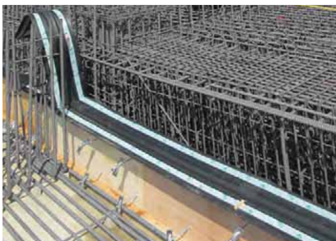
③ 止水板設置状況
