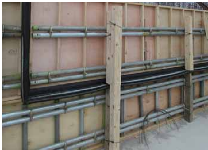
⑥型枠設置完了(コーナー部)
