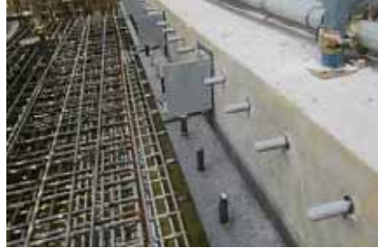
5. 鋼製枠設置（全景）
