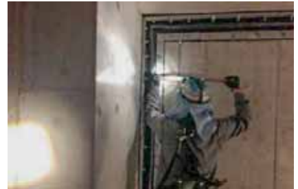
9. 締め付けトルク確認・袋ナット取付
