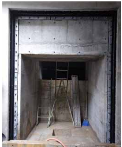
共同溝増築工事
