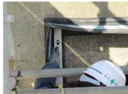
7. 押え板取付状況
