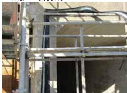
6. 伸縮ゴム取付状況
