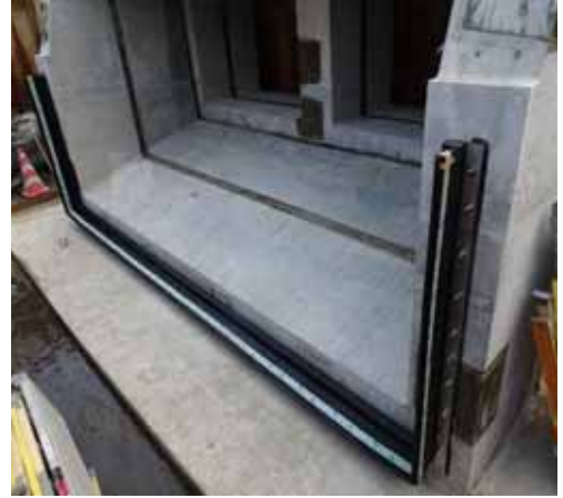
ポンプ場放流渠新設工事
