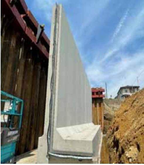
L 型擁壁新設工事
