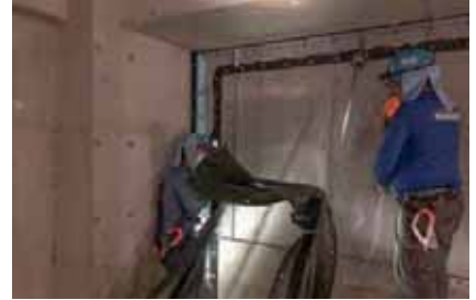
8. 保護シート・押え板取付
