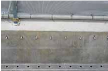
3. アンカーボルト打設
