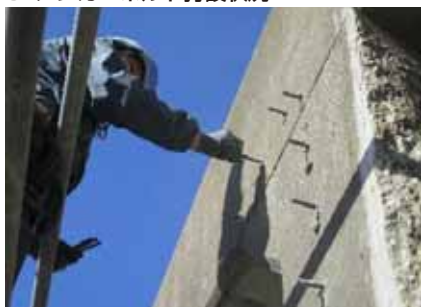
3. アンカーボルト打設状況
