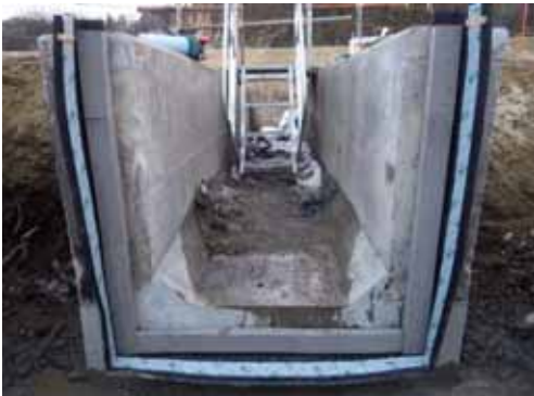
河川ゲート更新工事（樋管・樋門等）
