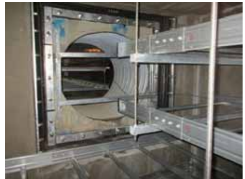
トレンチ増築工事
