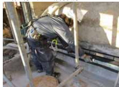
8. 締め付けトルク確認状況
