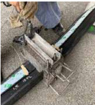
現地接合状況
