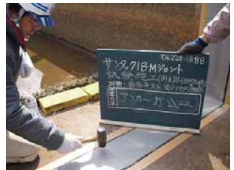
⑧ プラスチックアンカー打ち込み
