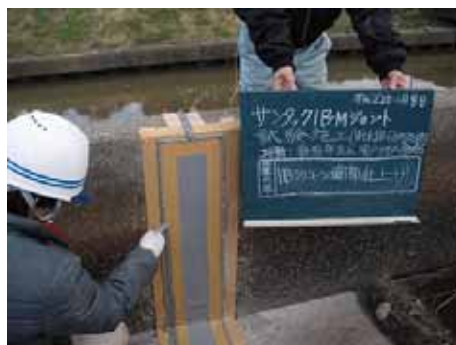
⑩ 端部仕上げ (段差処理) IBシリコン打設後の傾斜付け
