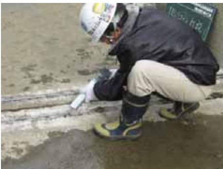
⑥ (例2) IBシリコン打設 (下地に直接打設)
