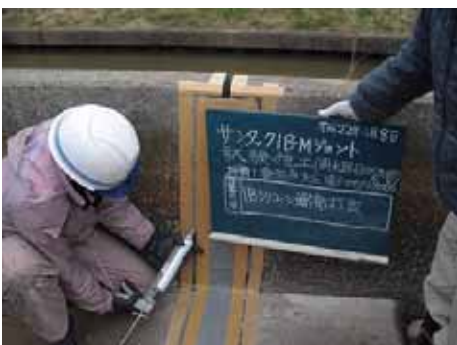
⑨ 端部仕上げ IBシリコン打設
