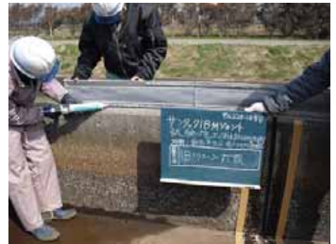
⑥ (例1) IBシリコン打設 (IB-Mジョイントに直接打設)
