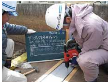
⑦ 穴あけ (ハンマードリル使用)
