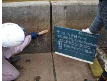
② 下地清掃 ブラシかけ・コンクリート面の汚れ落とし
