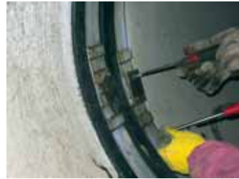
⑦ 押えカバー取り付け状況
