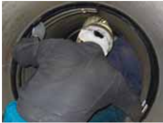
⑤ 拡張バンド設置状況
