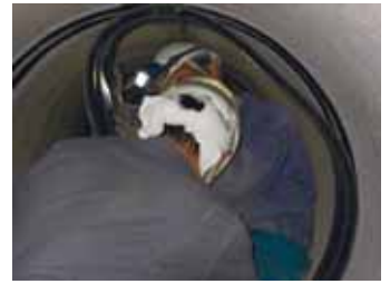
④ 本体ゴム位置合わせ状況
