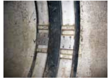
⑧ 押えカバー取り付け完了
