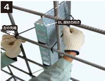
④ 左の先端を鉄筋にはめ込みます。
