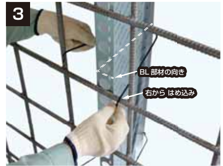
③ BL部材の向きが上図の場合は右からはめ込みます。
