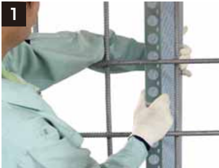
① 下げ振りを使用して垂直精度を確認し、取付位置に墨出した後、BL部材を設置して下さい。
