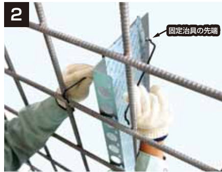
② BL部材の先端に固定治具の先端を当てます。
