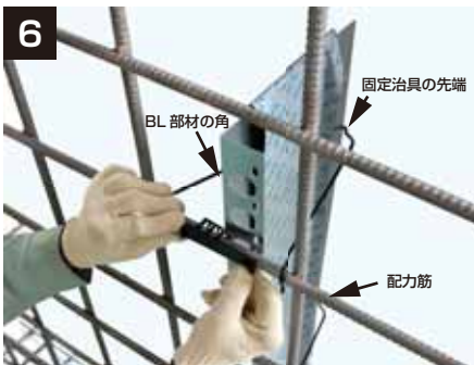
⑥ A部材用固定治具を配力筋にはめ込みBL部材の角と固定治具の爪をしっかりと当てて取付けます。
