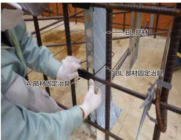
※ A部材固定治具取付状況
