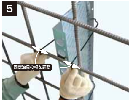
⑤-1 BL部材の固定が不安定な場合固定治具の幅を調整して下さい。
