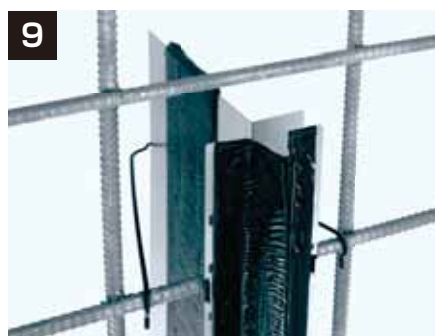
⑨ A部材、BL部材設置完了
