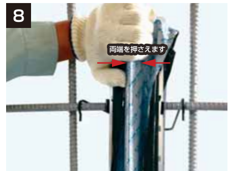
⑧ 差し込みの邪魔にならない様に、保護フィルムをはがし、A部材の両端を押さえます。
