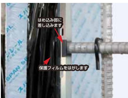
両端を押さえながら治具のはめ込み部に差し込んでください。
