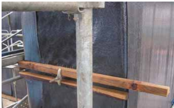
角材を用いて固定
