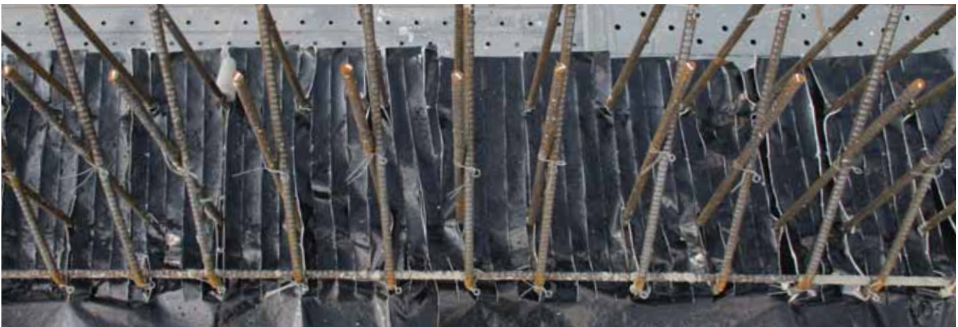
地覆キュア・敷設例
