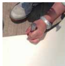
ポンチにて穴開け加工
