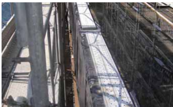
足場用踏み板で固定
